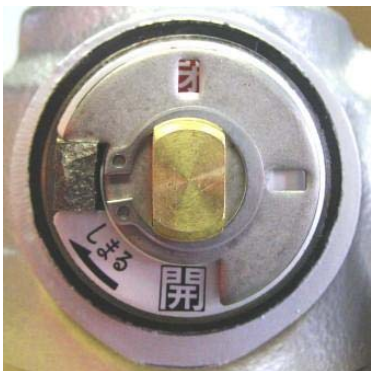
写真2 安全弁元弁「開」の状態
